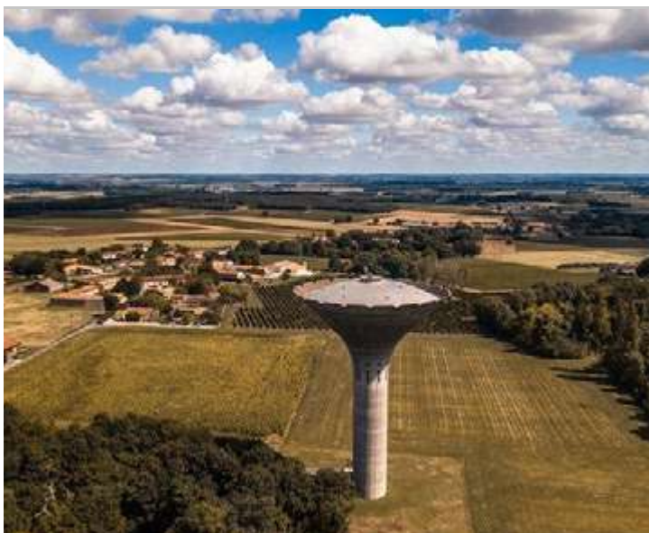
Château d'eau d'Asnières-la-Giraud (17)
