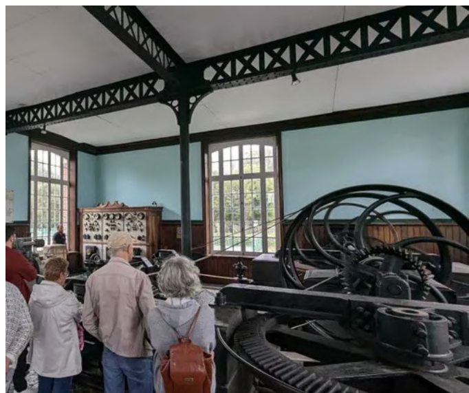
Centrale hydroélectrique de Long © BS3V
