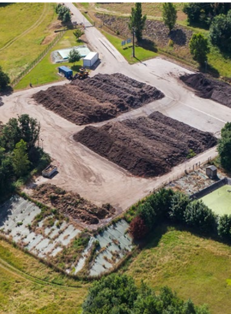
Plateforme de compostage d'Artigues, Lot-et-Garonne
