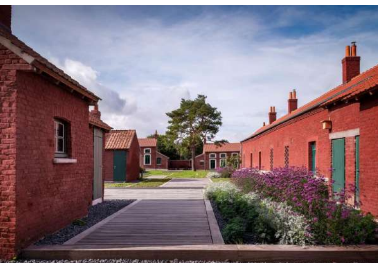
© Cité des électriciens
